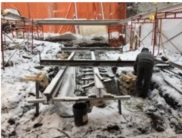
Figure 37-2 : Puis, une structure métallique a réuni toutes les plaques de soutien.
