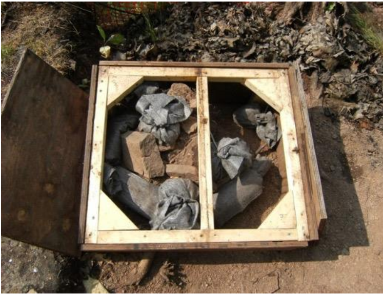
Figure 54 : Vue des vestiges consolidés à l'aide de petits sacs en géotextile, remplis de cailloutis. © André Bergeron, CCQ
