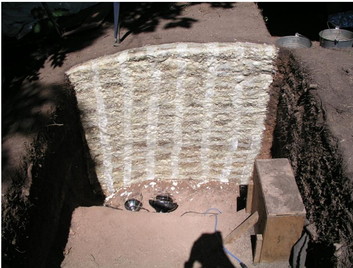
Figure 40 : Début de l'installation de bandelettes de renforcement. © Commission de la capitale nationale du Québec
