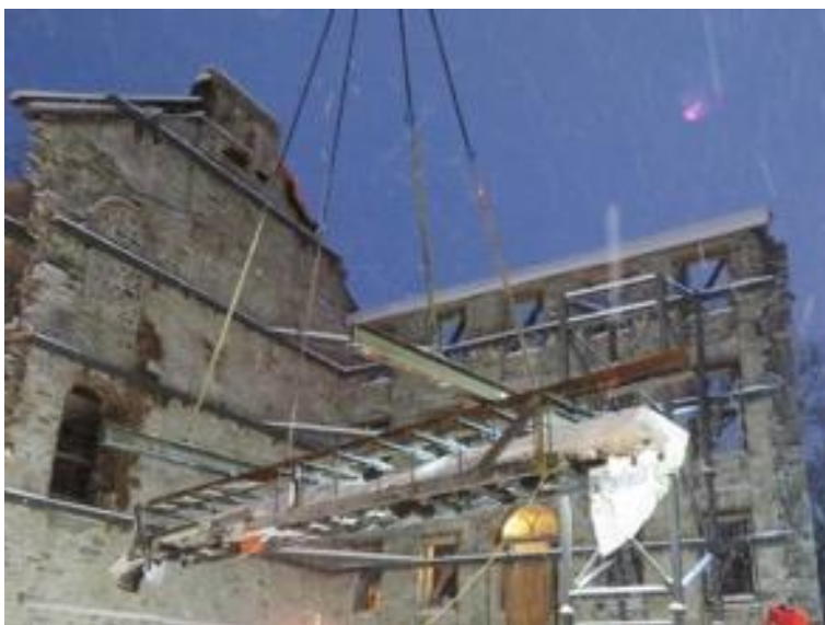
Figure 37-3 : Les pièces ont été progressivement dégagées du sol argileux à l'aide de vérins et la structure a été soulevée à l'aide d'une grue. © André Bergeron, CCQ
