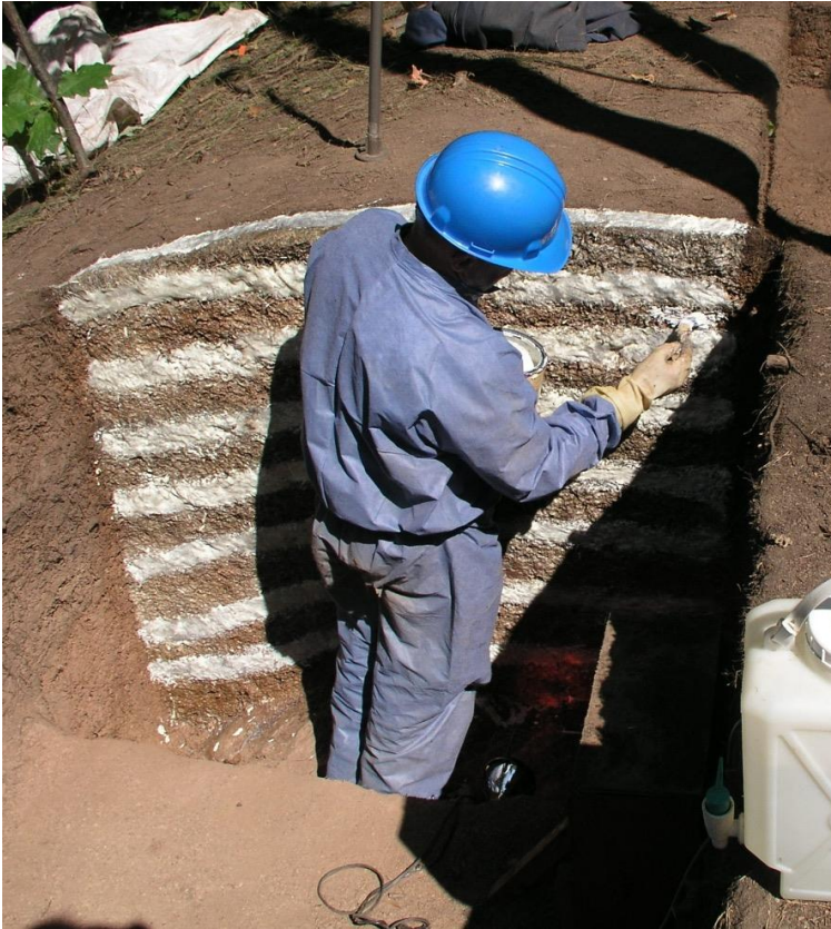
Figure 39 : Application de latex sur le sol à l'aide d'un pinceau. © Commission de la capitale nationale du Québec
