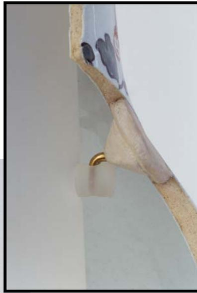
**Figure 86 :** *Détail d'un point d'ancrage du pot à bec verseur sur son support de plexiglas.*
